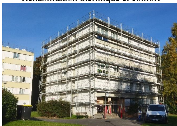
Les Andelys – Les Maraîchers. Réhabilitation thermique et confort
