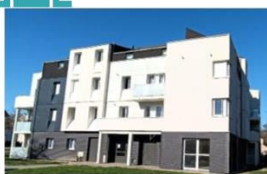
Evreux quartier St Michel 121 logements
