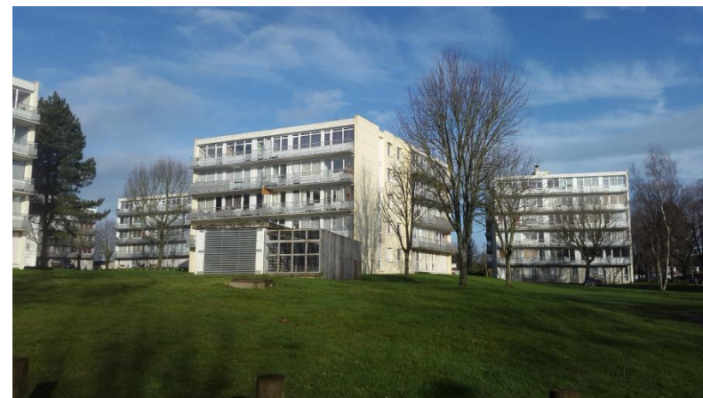
Résidence de logements sociaux collectifs SILOGE sur Bernay // Source : crédit MERC/AT
