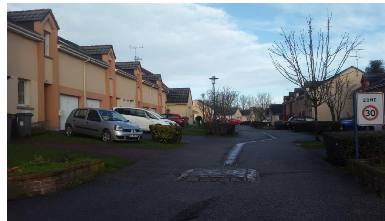
Résidence de logements sociaux individuels BAILLEUR sur Bernay // Source: crédit MERC/AT
