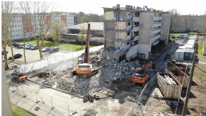
Déconstruction de 150 logements LOPOFA – Nétreville
