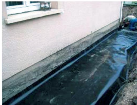
Figure 22 Géomembrane en cours de pose (Source Socabat)
