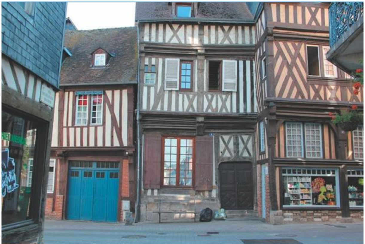
Bâtiments au 6-8 rue Auguste Leprevost - pan de bois du XV e -XVI e siècles
