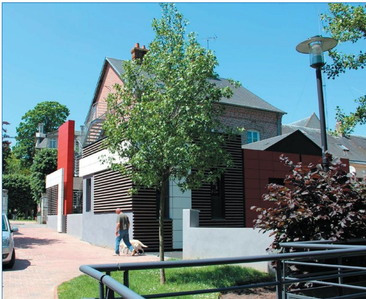
Place Escande - la façade en bardage bois ajouré aurait été davantage mise en valeur par une plus grande sobriété des formes et des couleurs
