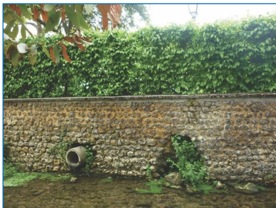
Deux exemples de murs parapets en moellons de silex encadrant respectivement la Charentonne et le Cosnier. Noter sur la photographie l'altération du mur percé sans ménagement de drains
