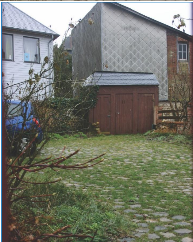
Trois exemples de cours de service, respectivement en pavé de grès (aujourd'hui disparus) avec reprises en ciment, en pavé de grès avec des joints herbeux et en gravier de silex avec un trottoir en brique
