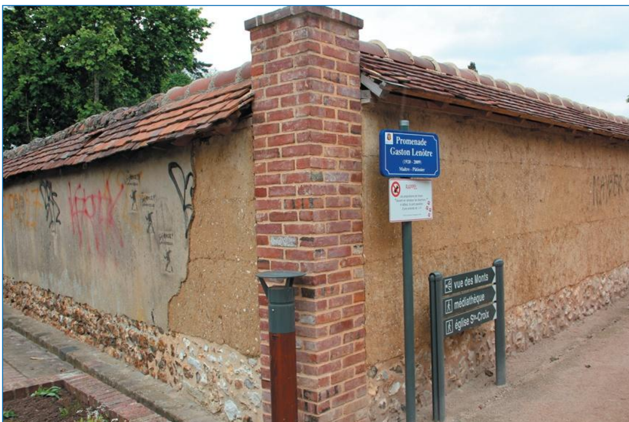
Promenade Gaston Lenôtre - murs en bauge restaurés
