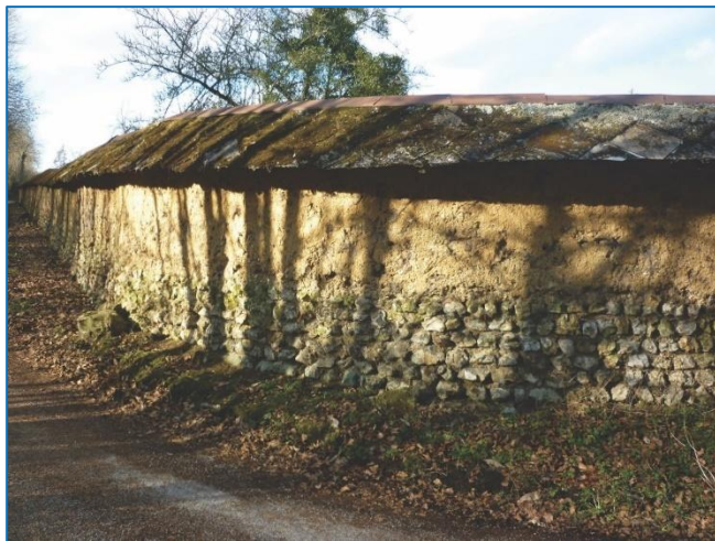
Exemples de murs en bauge. A droite, dispositif en bois, à l'état de vestige, initialement placé pour conduire des fruitiers en espalier.
