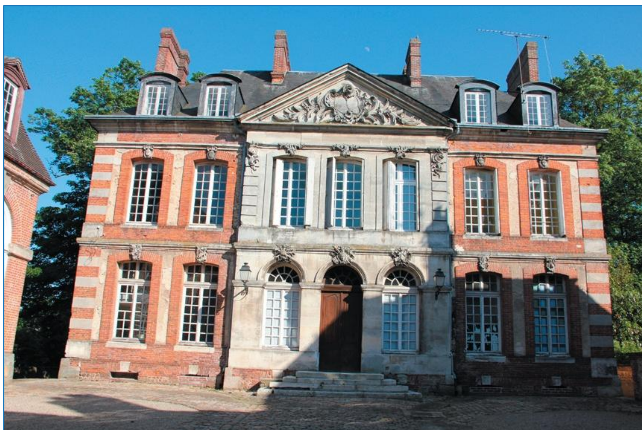
Hôtel de la Gabelle XVIII e - avant-corps central en pierre, le reste est en pierre, brique et enduit
