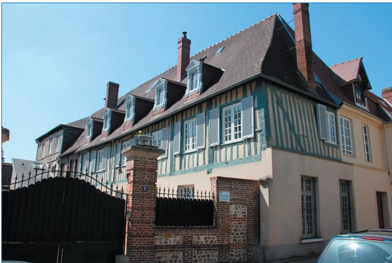
Couvent des Cordeliers, rue de la Comédie (XVII e )- toiture en tuile plate
