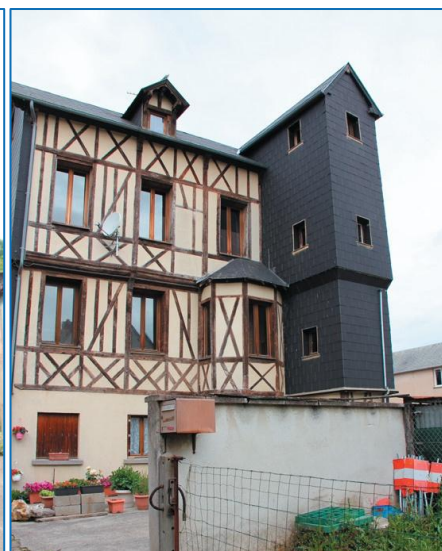
Rue Bernard Gombert - façades dégradées en ardoise bleu et en carrés de fibrociment rouge / Tourelle en pan de bois recouverte d'ardoise en fibrociment
