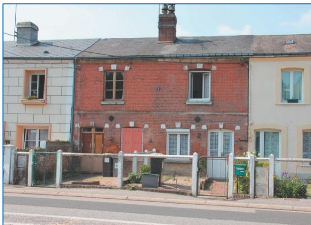
Rue Assegond / Rue d'Orbec : maisons ouvrières
