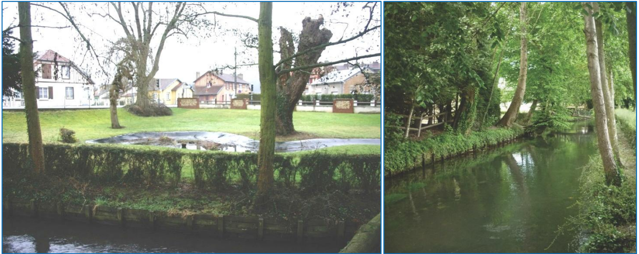
Exemple de mur de retenu d'eau en palplanche en bois le long du Cosnier, square Gouas
