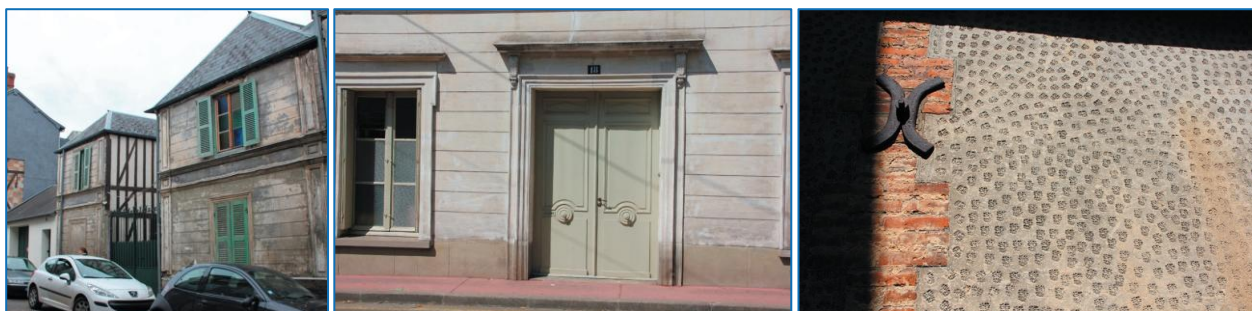
Rue Alexandre - façade en plâtre avec pilastres et faux-joints sur une structure en pan de bois / Rue Auguste Leprevost - la façade peut être traitée en une seule couleur, car elle imite le parement en pierre de taille / Impasse rue Gabriel Vallée - enduit décoré d'un motif imprimé
