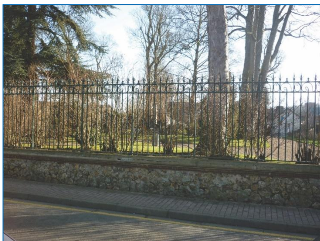
Deux exemples de murs bahut en soubassement de silex, surmontés d'un ouvrage en fer forgé travaillé. A droite, occultation par des tôles festonnées
