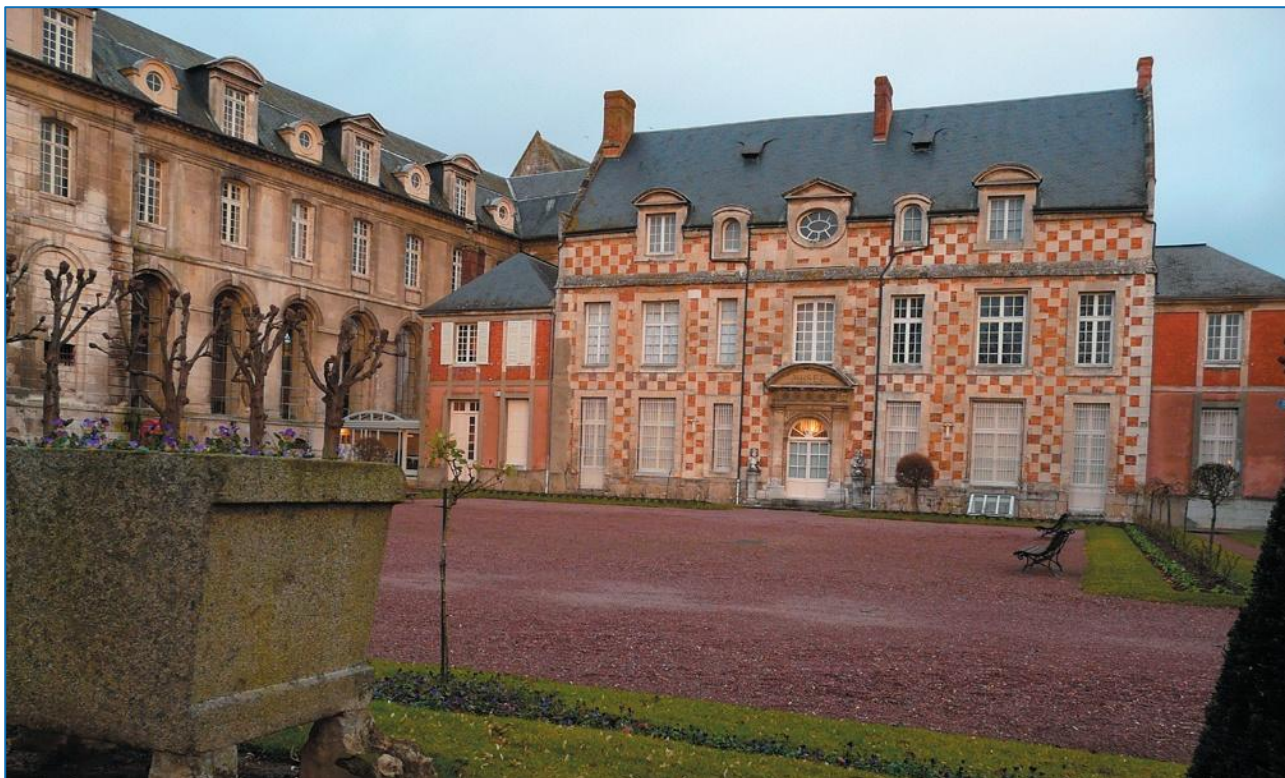
Logis abbatial et bâtiments conventuels couverts d'ardoise
