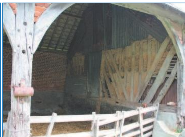
Malharquier : hangar en bois, fermeture moderne en brique
