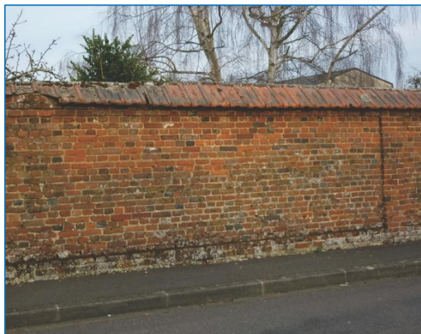
Exemples de murs en brique surmontés d'un chaperon à double pente en tuiles mécaniques ou en plaques de fibrociment. A droite, vestiges de l'ossature en bois initialement placée pour conduire des fruitiers en espalier.
