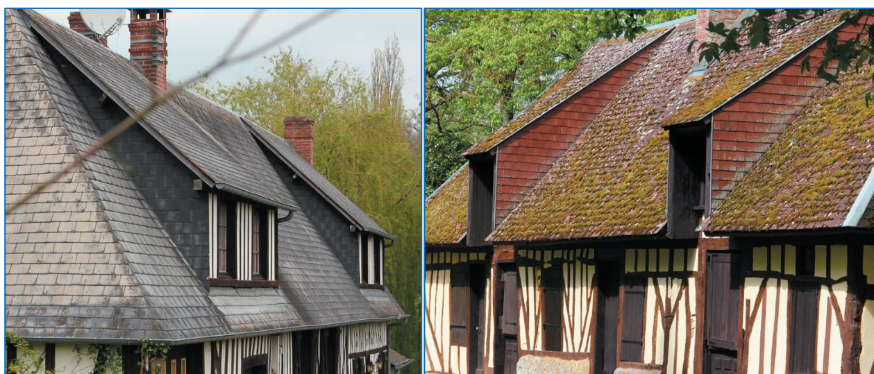
Fermes restaurées à Carentonne et Champeaux - Les lucarnes rampantes sont héritées de l'architecture en chaume, mais cette forme est inhabituelle pour les couvertures en tuiles ou ardoise.
