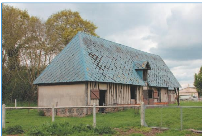
Les Chesnets : bâtiment agricole en brique, avec pan de bois décoratif, transformé en habitation / Malharquier : grange en pan de bois et torchis
