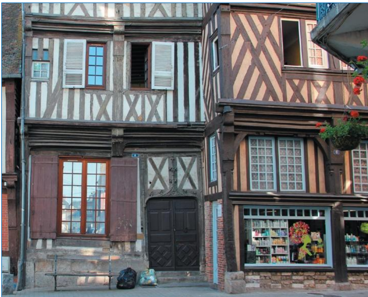
A droite, menuiseries à petits bois cohérentes avec le bâti ; à gauche, fenêtre rez-de-chaussée plus tardive et persiennes modernes
