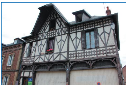
Rue des Fontaines - maison atelier avec étage en brique doublée de pan de bois décoratif / Rue du 11 Novembre - façade Art Nouveau en cadres et panneaux bois / Rue Léon Puel - structure en brique peinte d'un décor de faux pan de bois
