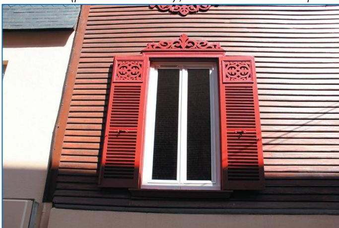
Menuiseries à petits bois sur un atelier XIX e - les proportions des baies de l'étage sont exagérées / Les motifs en bois découpé ne sont pas cohérents avec les formes locales et la couleur est trop voyante
