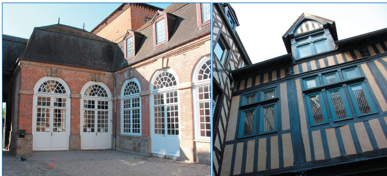
Menuiseries XVIII e à petits bois / Menuiseries XVI e à vitraux losangés
