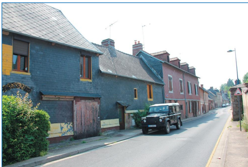
Rue Bernard Gombert - façades dégradées en ardoise bleu et en carrés de fibrociment rouge / Tourelle en pan de bois recouverte d'ardoise en fibrociment
