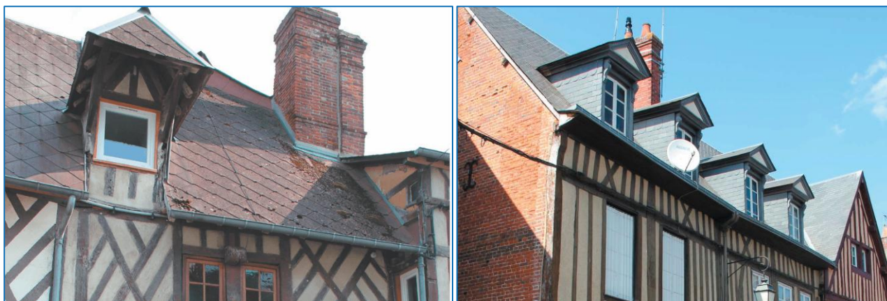
Lucarne pignon à croupe en pan de bois, couverture fibrociment dissonante / Lucarnes à fronton en bois peint
