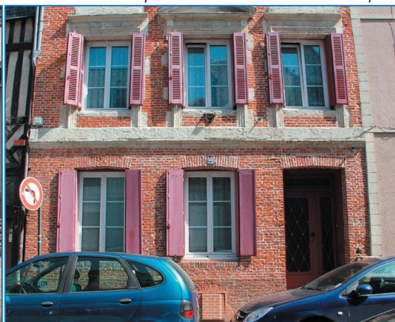
Menuiseries modernes en bois à vitrage unique, sur une maison XVII e en pan de bois / Menuiseries modernes discordantes (petits bois collés) ; volets de couleur trop rose
