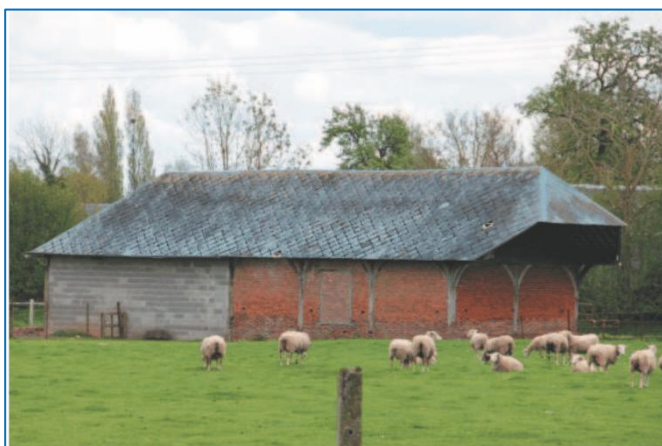
Les Chesnets : bâtiment agricole en brique, avec pan de bois décoratif, transformé en habitation / Malharquier : grange en pan de bois et torchis
