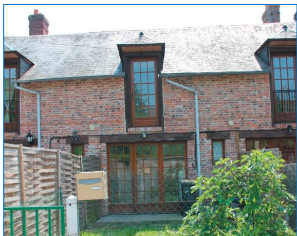
Menuiseries à petits bois sur un atelier XIX e - les proportions des baies de l'étage sont exagérées / Les motifs en bois découpé ne sont pas cohérents avec les formes locales et la couleur est trop voyante
