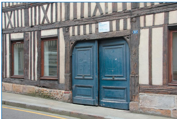
Menuiseries modernes en bois à vitrage unique, sur une maison XVII e en pan de bois / Menuiseries modernes discordantes (petits bois collés) ; volets de couleur trop rose
