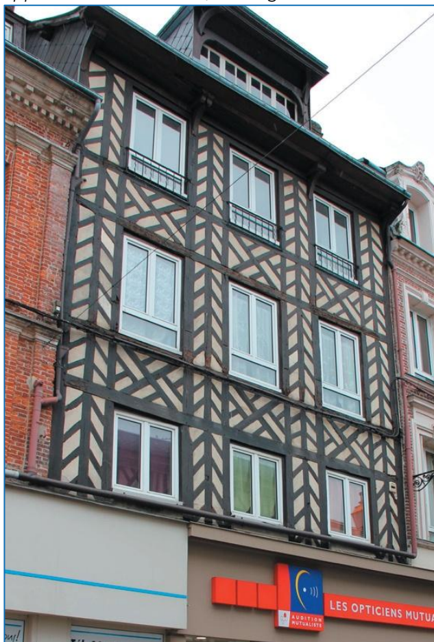
Remplissage en tuileaux / Bâtiment d'habitation rue Thiers du XIX e siècle, à l'origine recouvert d'enduit
