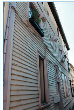
La Logerie, hangar - bardage vertical à couvre-joints / Rue Assegond - pan de bois habillé de lames de bois peintes / Impasse rue Gabriel Vallée - véritables clins de bois
