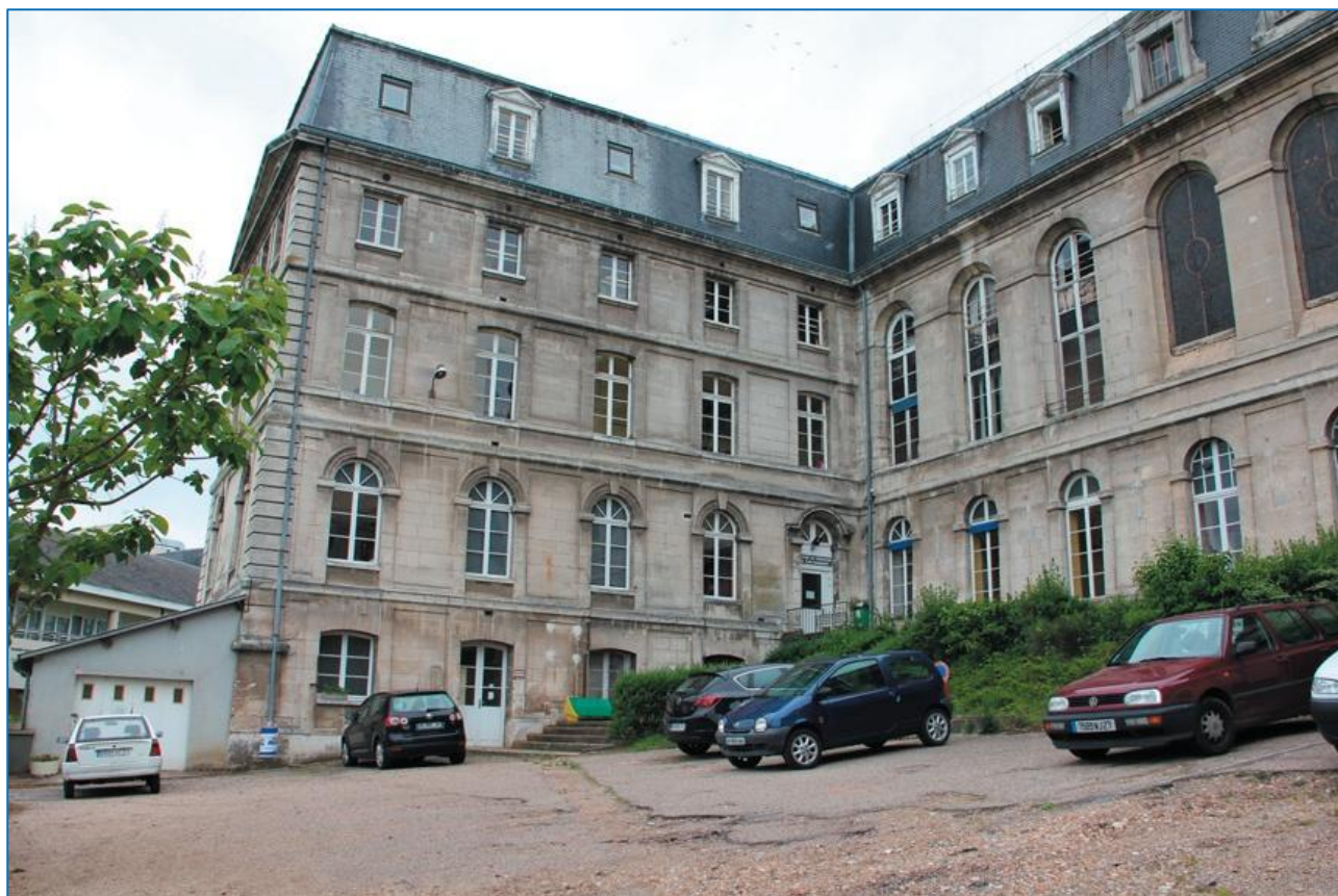
Hospice de Bernay - bâtiment du début XVIII e en de taille
