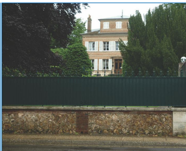
Deux exemples de murs bahut en soubassement de silex, surmontés d'un ouvrage en fer forgé travaillé. A droite, occultation par des tôles festonnées
