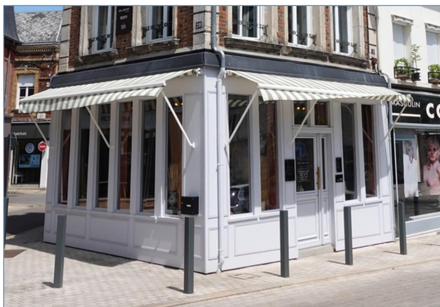
Devanture XIX e en bois posée en applique / Rez-de-chaussée modifié, avec devanture vitrée saillante en alignement de la rue
