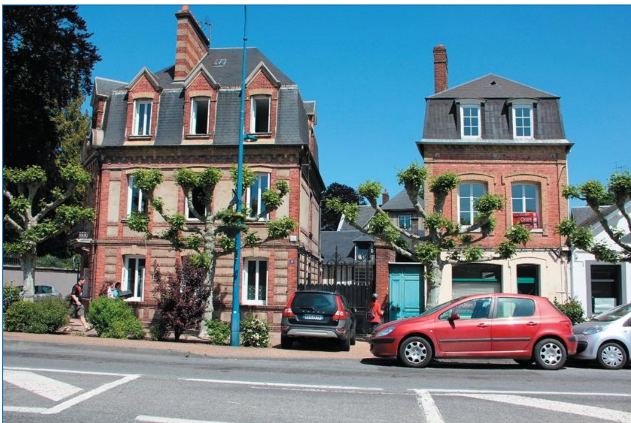
Villas boulevard Dubus - combles à la Mansart en ardoise
