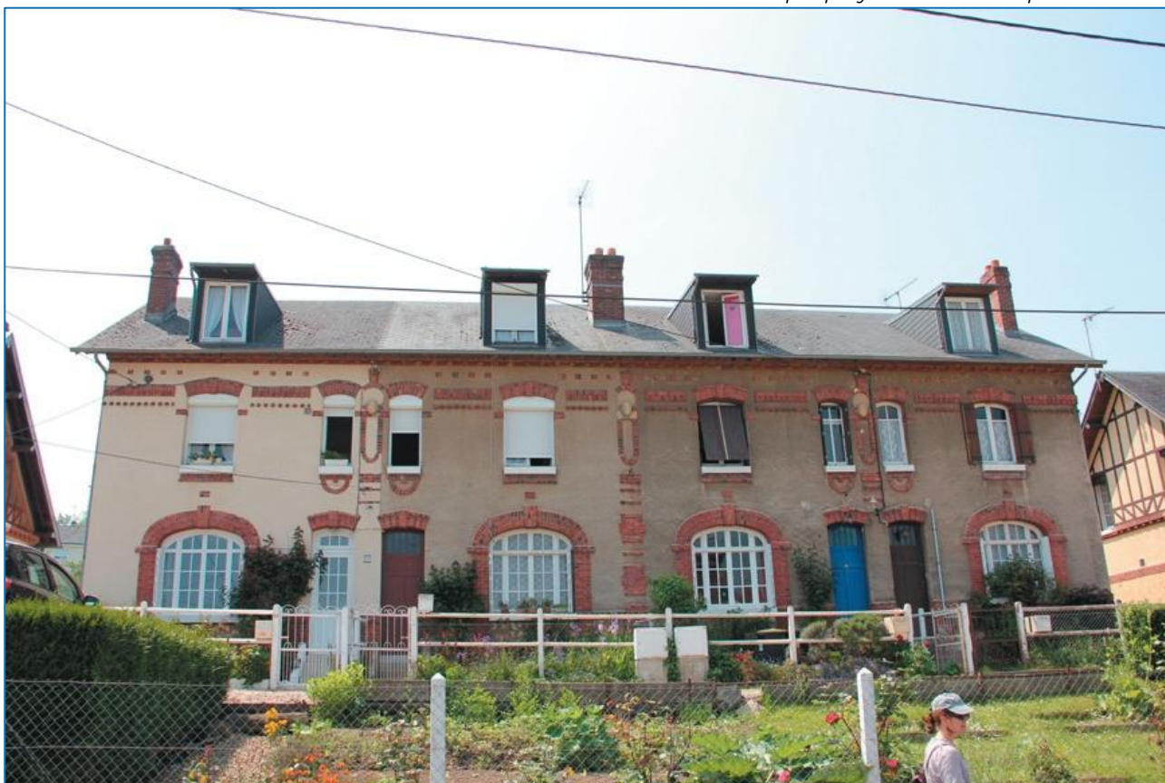
Maisons de contre-maître, rue Kléber Mercier - brique enduite avec encadrements apparents
