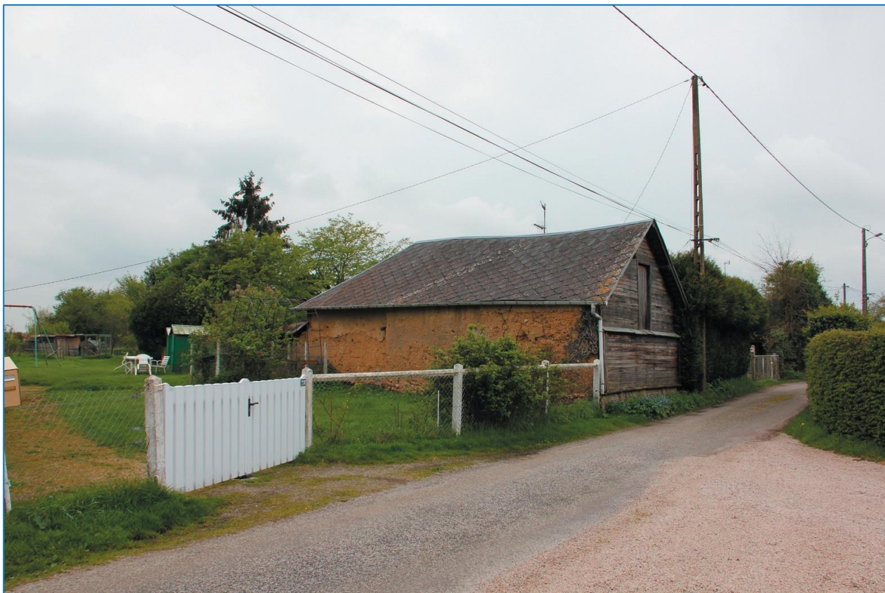
Hameau de Bouffey - bâtiment en bauge et lames de bois
