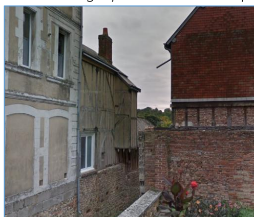
WC surplombant la rivière
