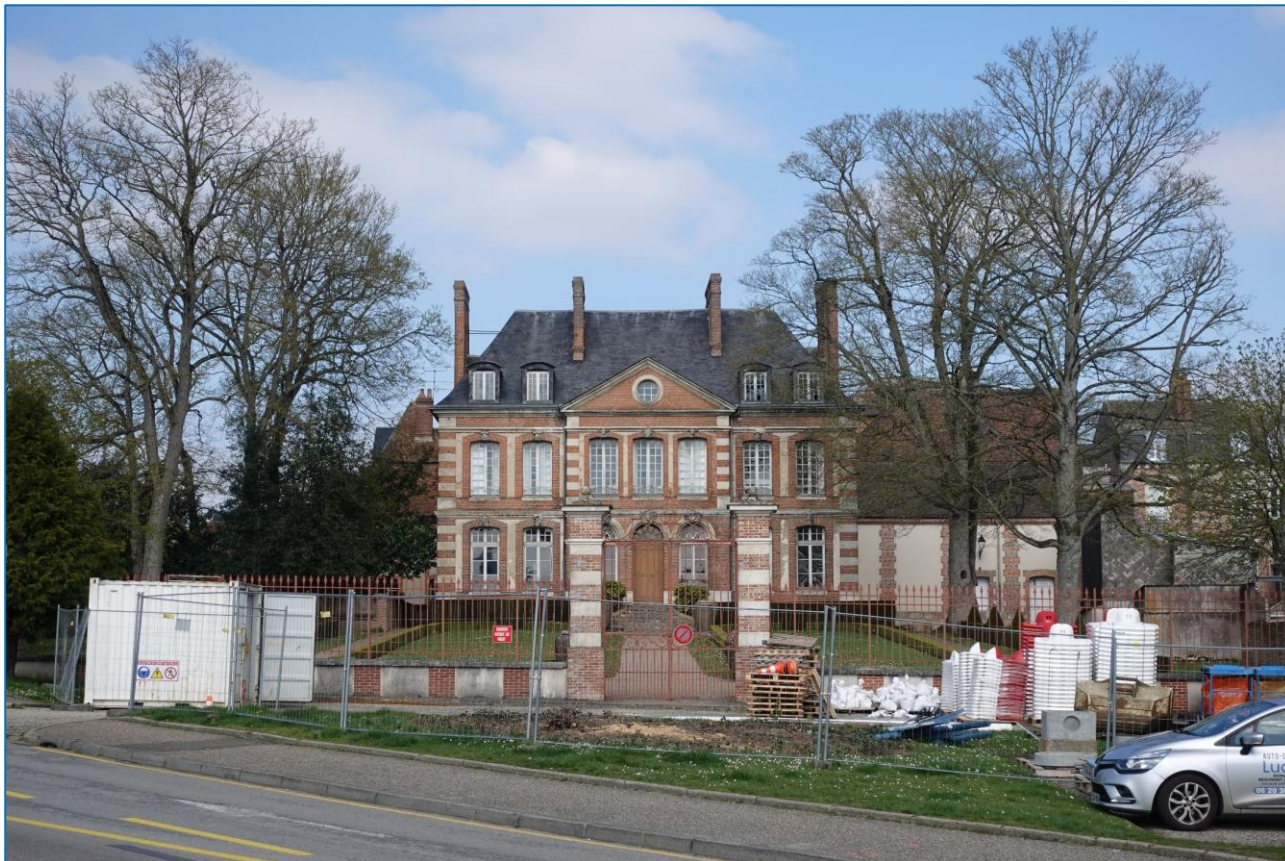
Photographie de l'ancien hôtel de la Gabelle
