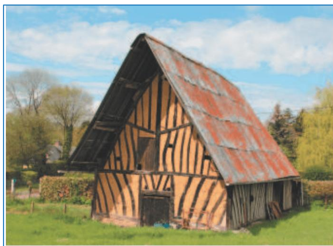
Pilette est : grange en pan de bois et torchis / Champeaux : grange ouverte en bauge transformée en habitation avec pan de bois de récupération
