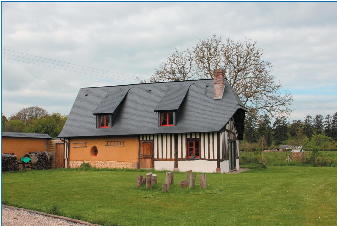
Hameau de Champeaux - ancien bâtiment agricole transformé en habitation : murs en bauge restaurés, pan de bois de remploi
