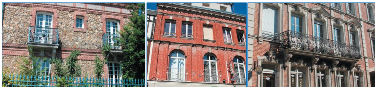
Garde-corps en fer forgé
