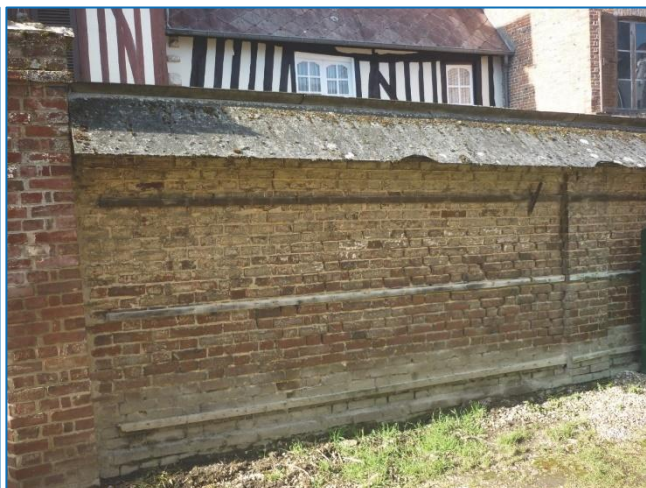
Exemples de murs en brique surmontés d'un chaperon à double pente en tuiles mécaniques ou en plaques de fibrociment. A droite, vestiges de l'ossature en bois initialement placée pour conduire des fruitiers en espalier.
