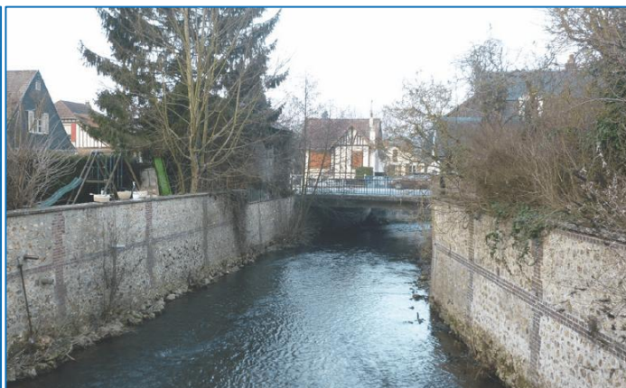
Deux exemples de murs parapets en moellons de silex encadrant respectivement la Charentonne et le Cosnier. Noter sur la photographie l'altération du mur percé sans ménagement de drains
