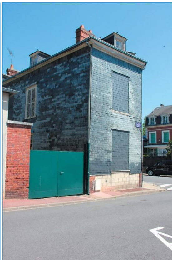
Rue des Poilus - étage en pan de bois recouvert en ardoise / Rue Leon Puel - l'ensemble des façades est en ardoise, compris l'occultation des baies
