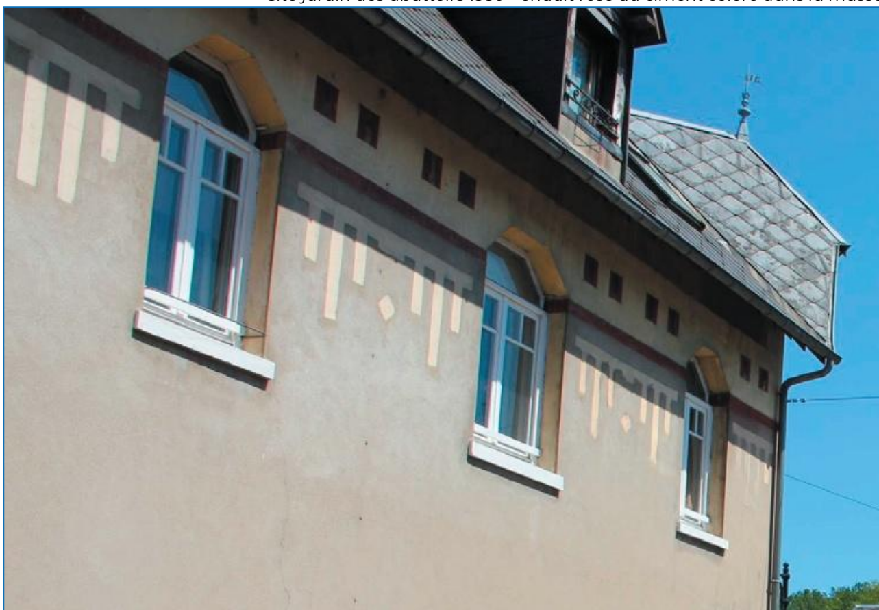
Immeuble rue de Charentonne décor polychrome (1930) sur un enduit au ciment
