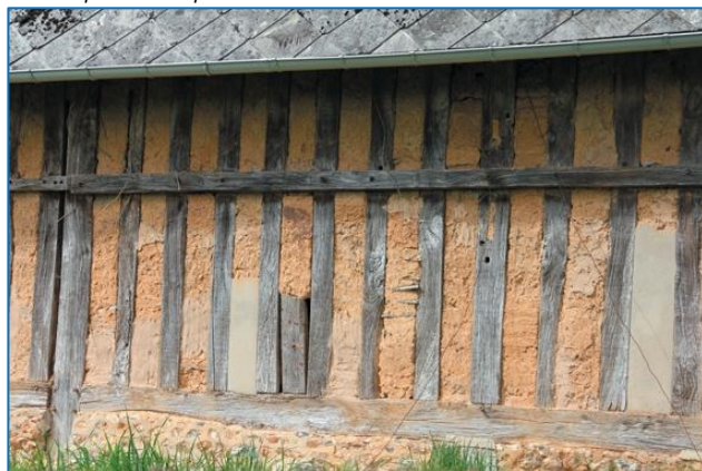
Bâtiment agricole à Pilette Est - pan de bois et torchis apparent
