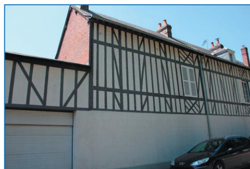
Rue des Fontaines - maison atelier avec étage en brique doublée de pan de bois décoratif / Rue du 11 Novembre - façade Art Nouveau en cadres et panneaux bois / Rue Léon Puel - structure en brique peinte d'un décor de faux pan de bois
