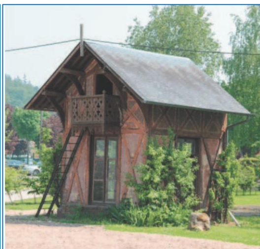
Rue Bernard Gombert : bâtiments de l'usine Gallant transformés en logements / Friche Varin-Pichon : kiosque en pan de bois et brique en mauvais état
