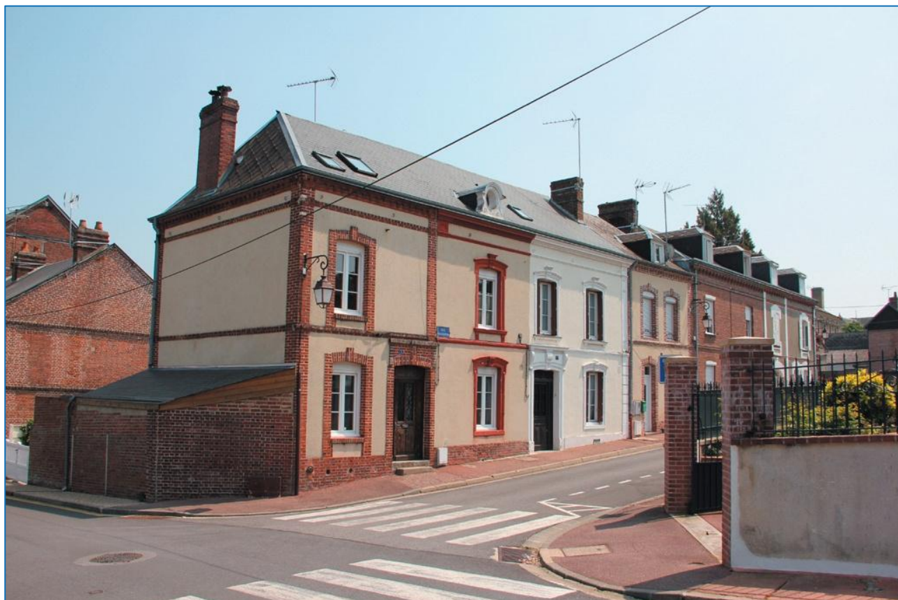
Rue Taillefer - traitement différent de la façade divisée entre deux propriétaires
