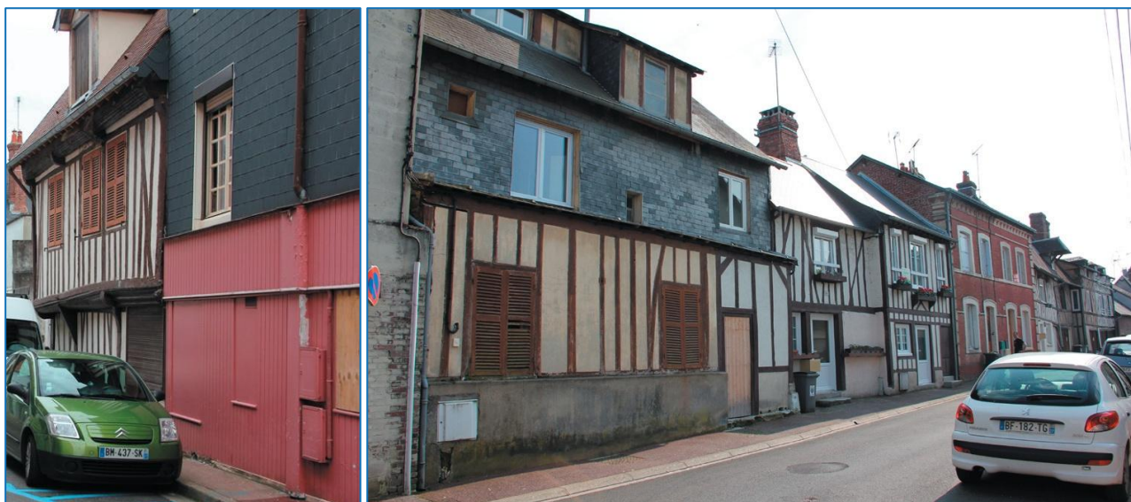
Traitement hétérogène de la façade en ardoise de fibrociment et bardage rouge / Rue Assegond – surélévation recouverte d'ardoise
