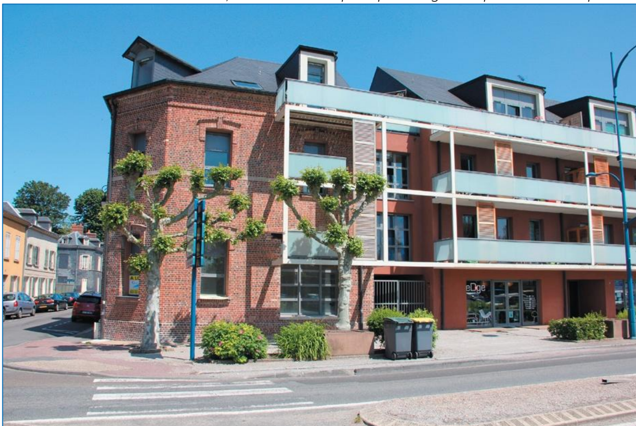
Ancienne cidrerie, puis caserne de Pompiers rue Gambetta. L'extension récente boulevard Dubus en enduit rouge reprend le gabarit et la couleur, mais les balcons filants apportent une note discordante.
