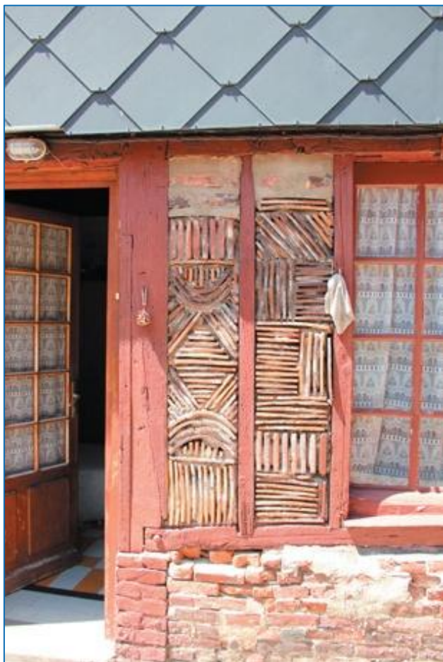
Remplissage en tuileaux / Bâtiment d'habitation rue Thiers du XIX e siècle, à l'origine recouvert d'enduit
