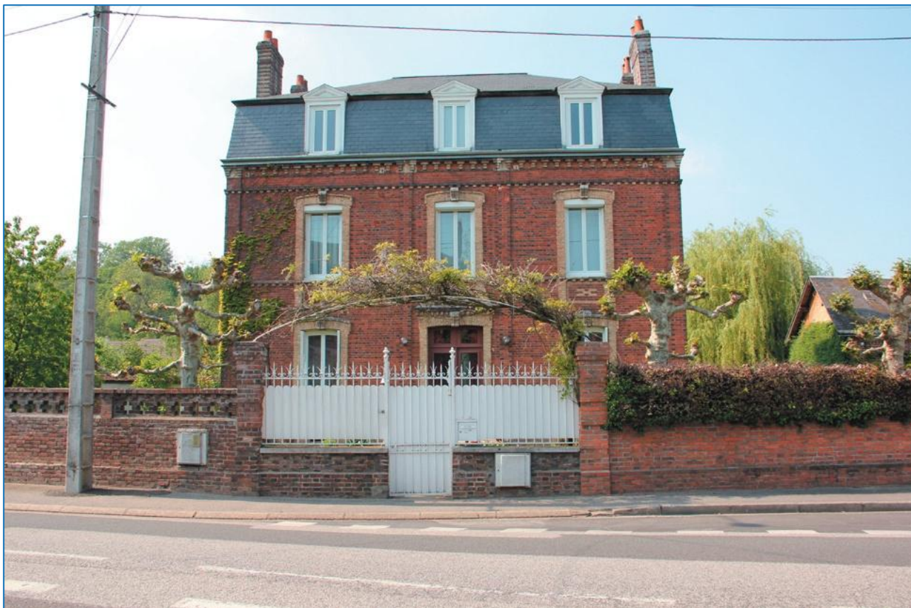
Villa rue d'Orbec - brique polychrome et brique vernissée
