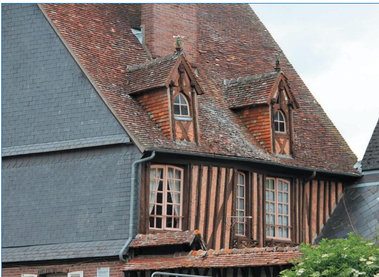
Lucarnes pignon en pan de bois, couverte en tuile plate
