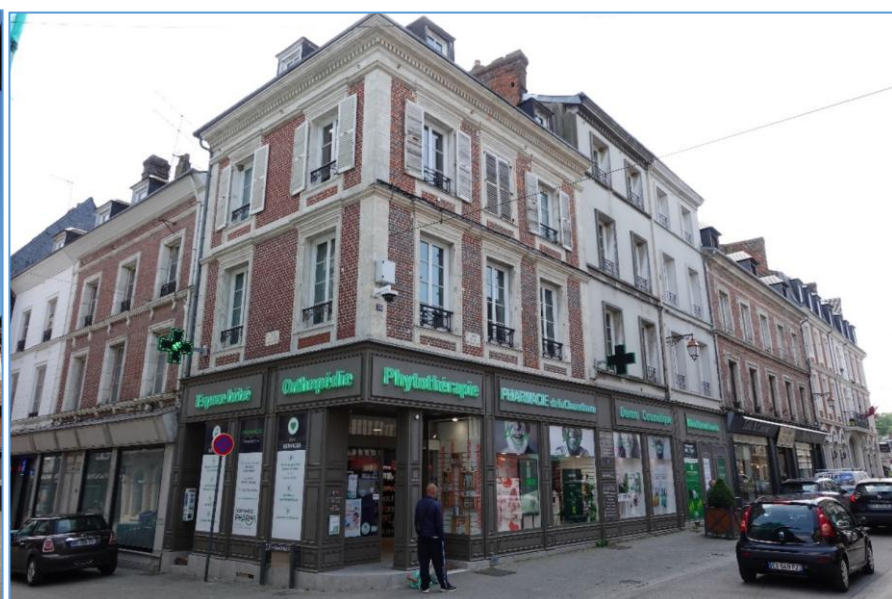
Devanture en feuillure / Devanture en applique en bois récente
