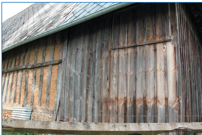
La Logerie, hangar - bardage vertical à couvre-joints / Rue Assegond - pan de bois habillé de lames de bois peintes / Impasse rue Gabriel Vallée - véritables clins de bois
