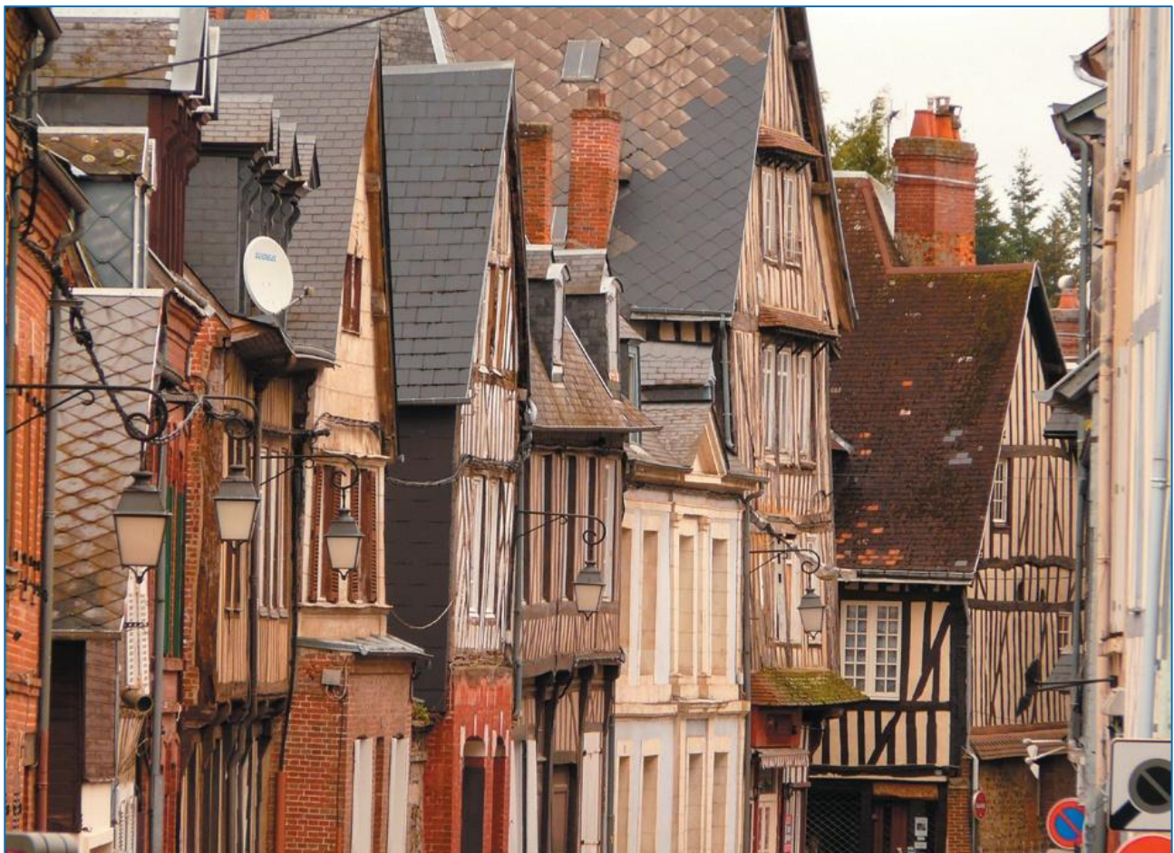
Rue Gabriel Vallée - toitures en ardoise et fibrociment
