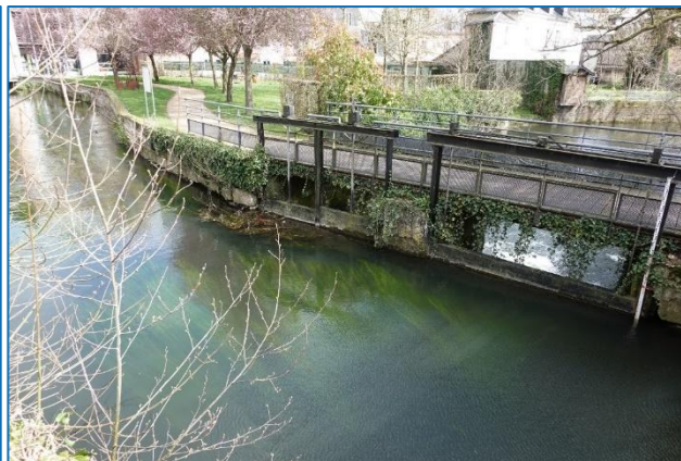
Lavoir et vannage sur la Charentonne
