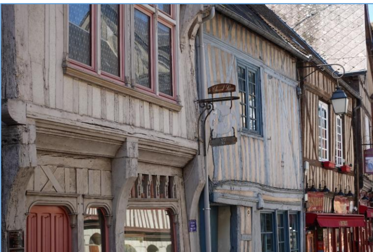
Devanture XIX e en bois posée en applique / Vitrines en feuillure, intégrées dans les baies, avec enseigne métallique en drapeau
