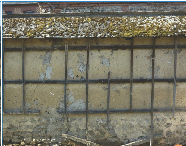
Exemples de murs en bauge. A droite, dispositif en bois, à l'état de vestige, initialement placé pour conduire des fruitiers en espalier.
