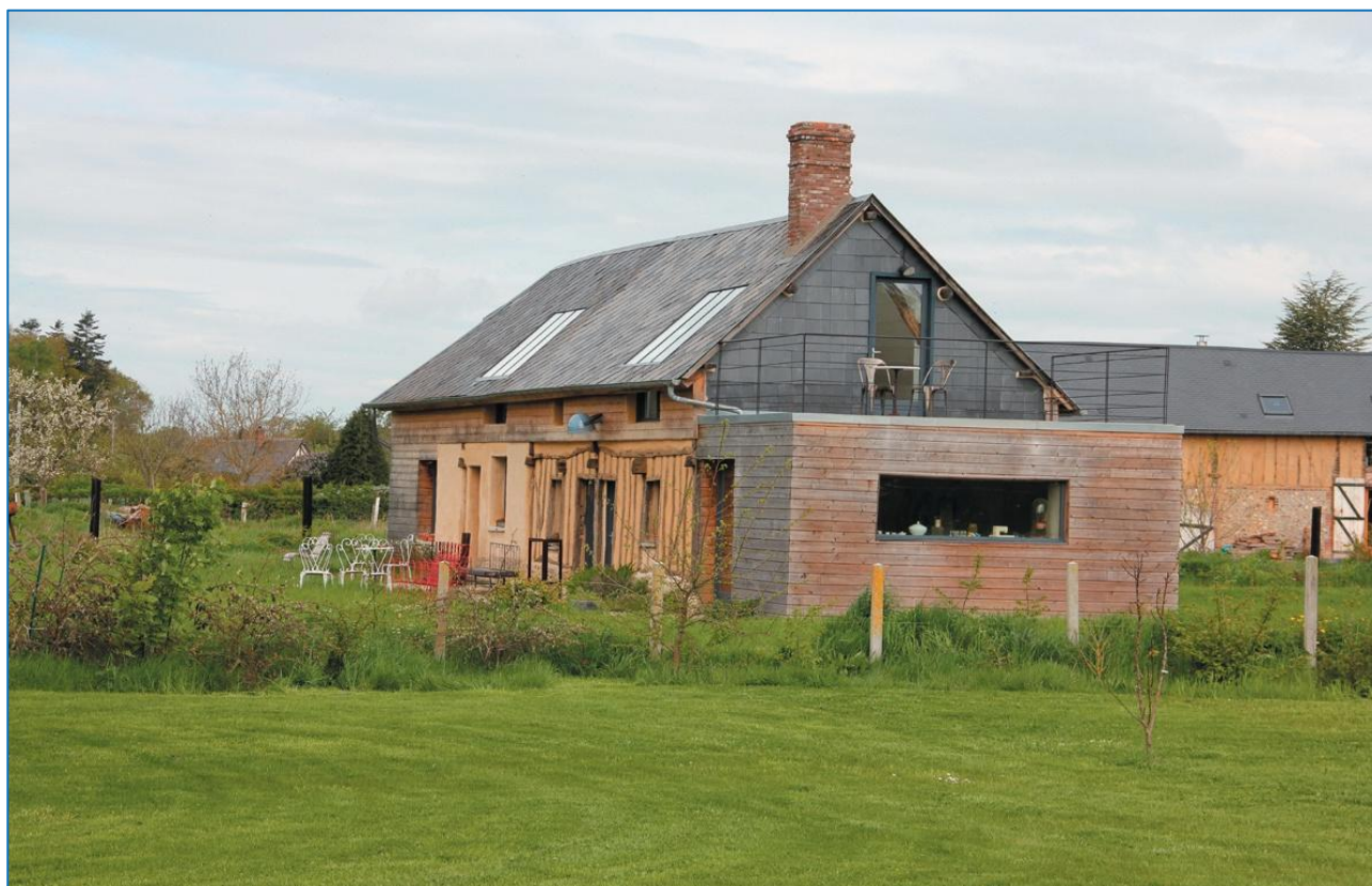
Maison individuelle à Champeaux - l'extension en bois s'intègre bien par son traitement et son gabarit. En revanche, il y a trop de matériaux différents sur la façade principale.
