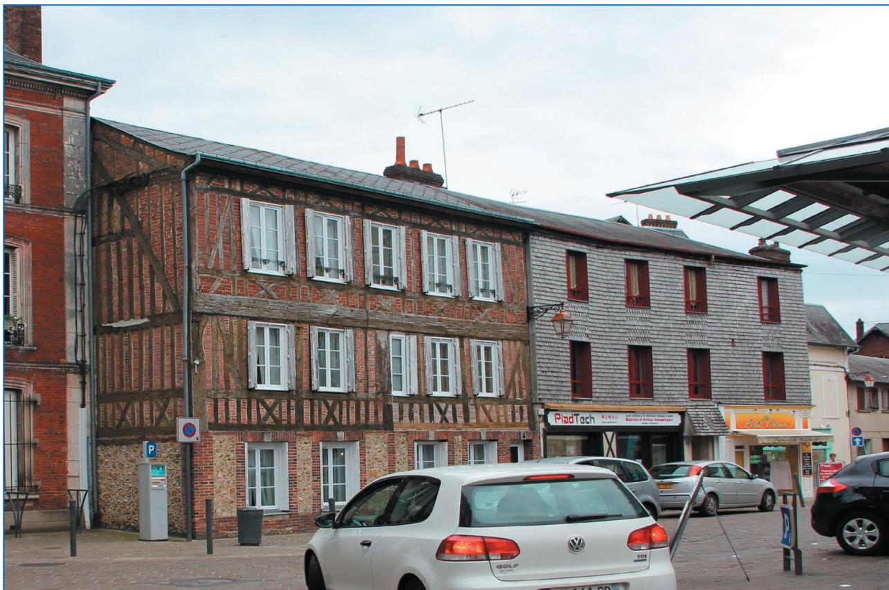
Place Sainte-Croix - façade restaurée en essentes
