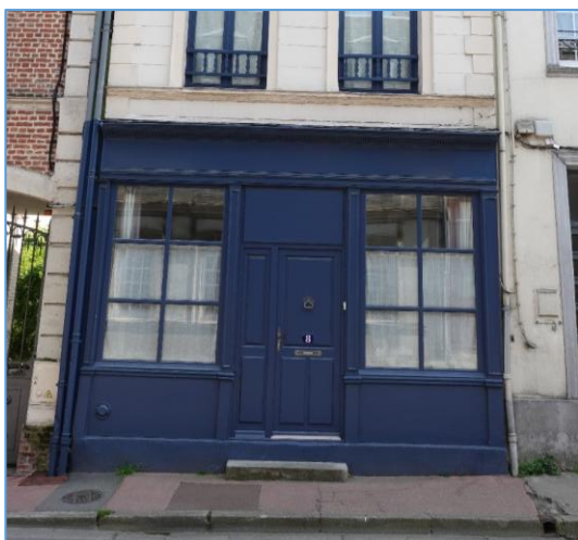
Devanture XIX e en bois posée en applique / Vitrines en feuillure, intégrées dans les baies, avec enseigne métallique en drapeau
