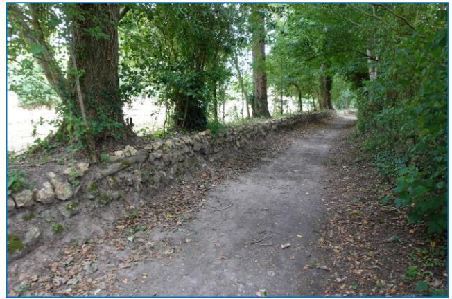
Mur en bauge au Bois Taillefer / Talus en silex armé à Champeaux
