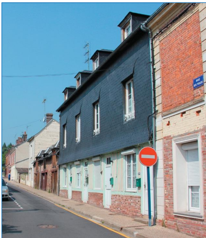
Rue des Poilus - étage en pan de bois recouvert en ardoise / Rue Leon Puel - l'ensemble des façades est en ardoise, compris l'occultation des baies
