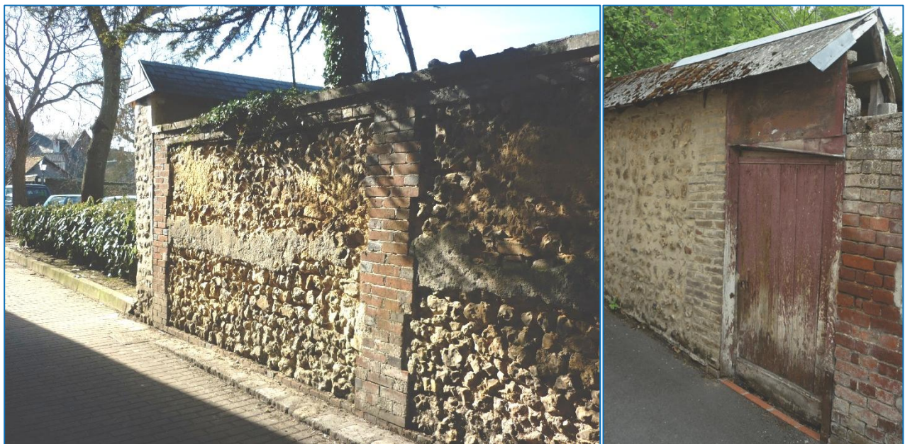
Exemples de mur en moellons de silex avec des harpes en briques (couronnement avec un chaperon à deux pentes ou à profil plat) / Porte d'accès en bois
