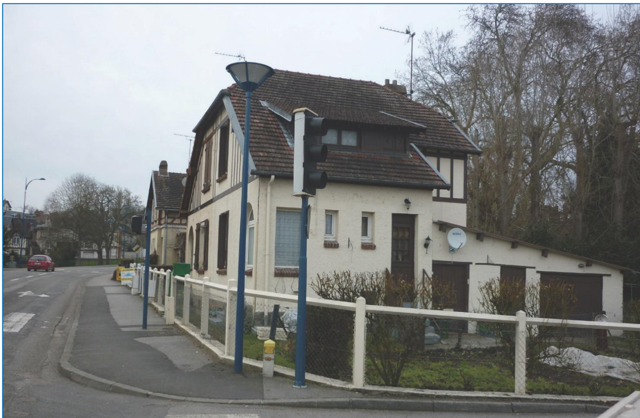
Clôture en béton préfabriqué
