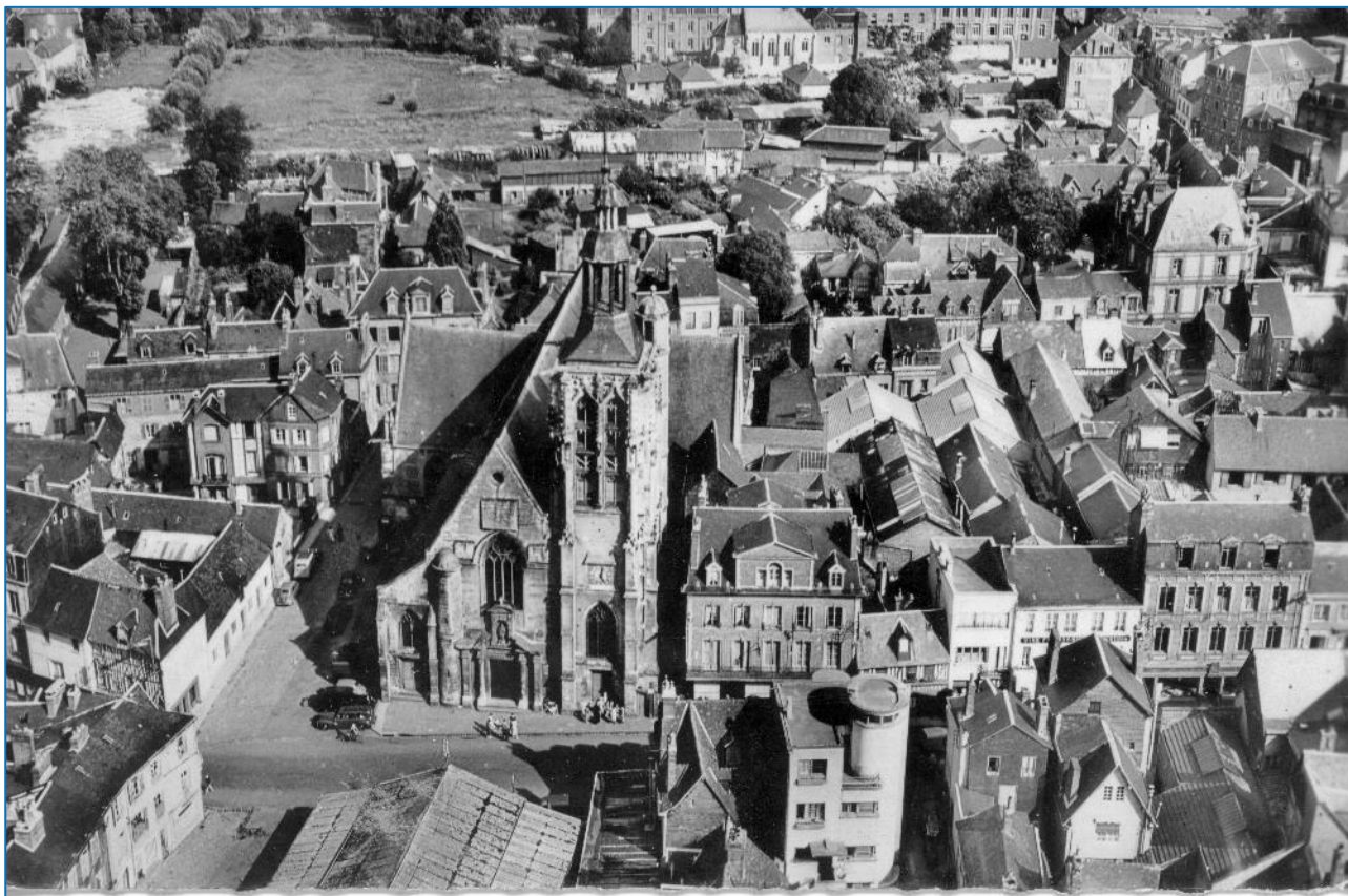
Eglise Sainte-Croix (source collection photographique CIM)
