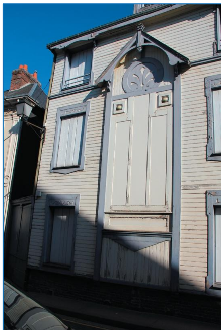
Maison rue Descours (début XX e ?) - façade en lames de bois peintes / Impasse Alexandre - façade en lames de bois encadrements moulurés / Hameau de Bouffey - bâtiment agricole en lames de bois naturelles
