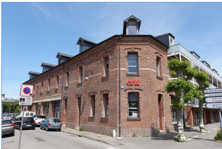
Immeuble à façades maçonnées monochromes (ancienne cidrerie de la rue Gambetta)
