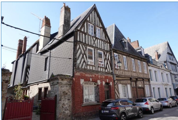
Immeuble de la rue Gabriel Vallée, avec des parties en pan de bois apparent, brique, silex et essentage d'ardoises
