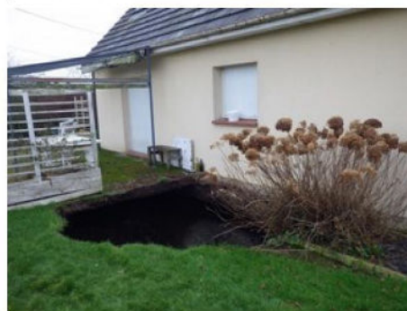
Effondrement d'une marnière, Saint Mards de Fresne. Source : DDTM27
