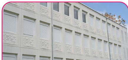
44 tabliers de volets roulants ont été remplacés à l'école primaire du Bourg-Le-Comte et la Cuisine centrale
