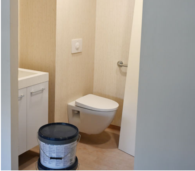
Salle d'eau d'un appartement de type T1 rénovée, dont les revêtements de mur et de sol sont entièrement lavables.
