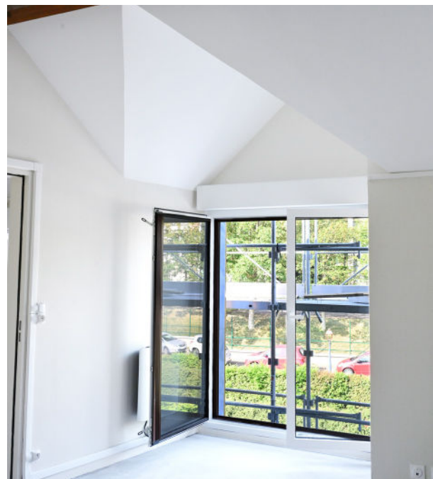
Les anciens bow-windows ont été habillé afin de contribuer à la performance énergétique des logements.
